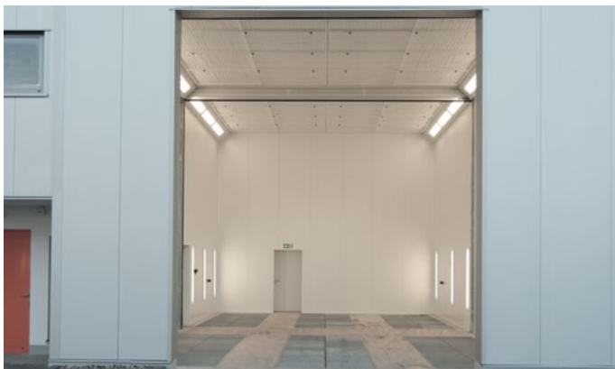
Lackierkabine, teilbar mit Trennwand, 12 m x 7 m x 6,8 m Jeder Bereich ist auch als Trocknungsraum nutzbar.
