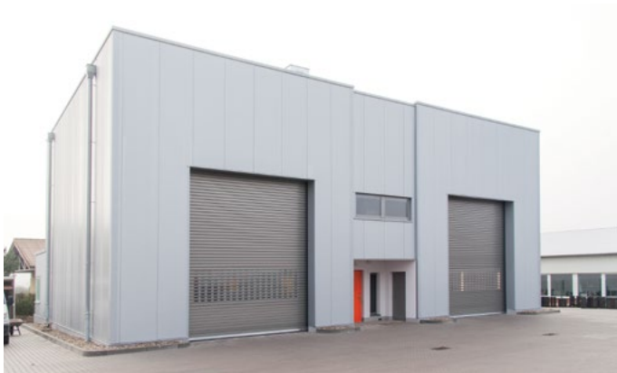
Lackierzentrum für die Lackierung von Schwerlaststaplern mit Washkabine (l.) und Lackierkabine (r.).
