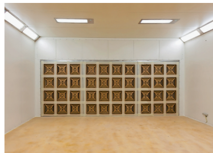
Die 36 m 2 große Lackierkabine mit den „Paintgrid“-Vorabscheidern.
